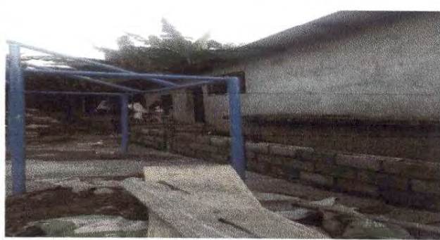
Foto 12: Reparación de tubo HG y malla galvanizada
