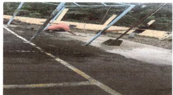
Foto 4: Sustitucion de piso torta de concreto
