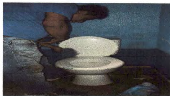
Foto 8: Sustitución de accesorios inodoro (contra llave, tubo de abasto, tanque) Sustitución de tapadera sanitaria.
