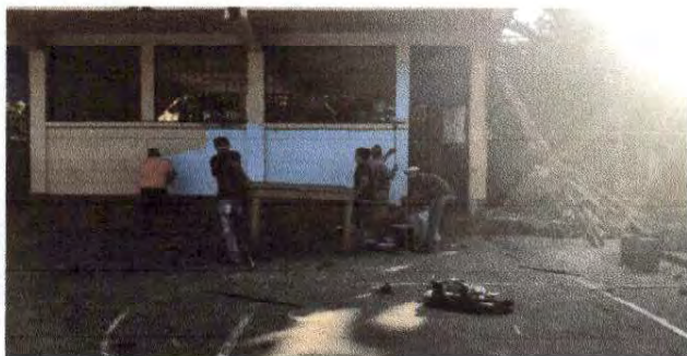
Foto 7: Pintura de muros exteriores e interiores
