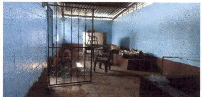
Foto 6: Pintura de muros exteriores e interiores
