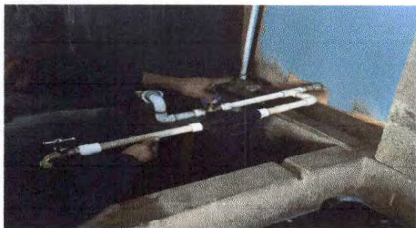
Foto 13: Sustitución de accesorios depósito de agua
