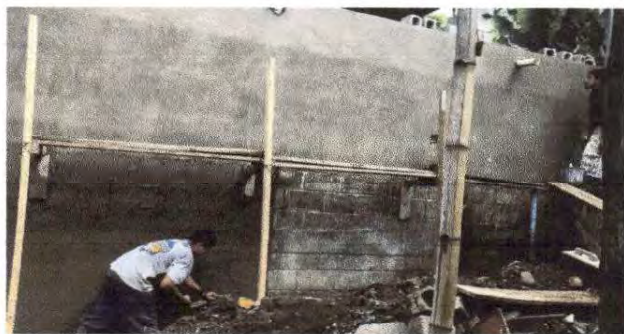
Foto 15: Repello en muro
