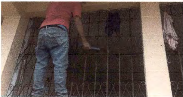
Foto 3: Mantenimiento a balcones de metal
