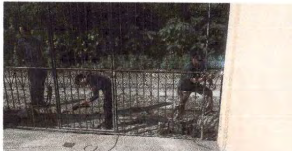
Foto 10: Mantenimiento a portones de metal
